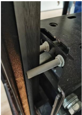
图 19.2-2 平层、强迫装置安装
