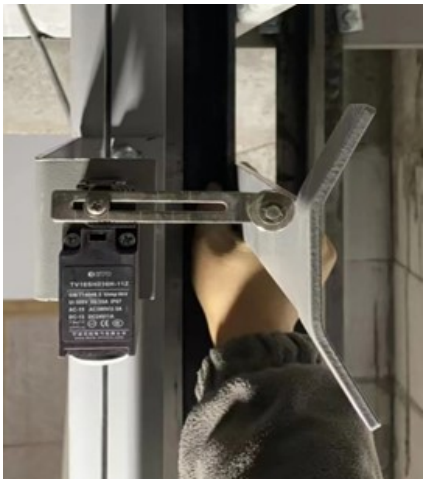
图 19.4-1 极限装置组合安装示意
