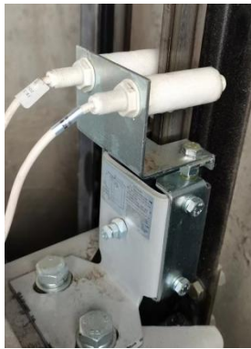
图 19.2-1 平层、强迫装置安装位
